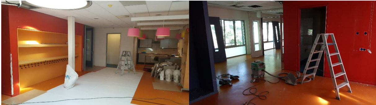
De verbouwing is begonnen, hier komen onze lokalen.
